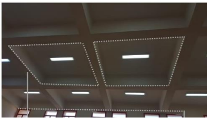
شكل رقم (15) الإضاءة الصناعية بسقف الفناء الداخلي (المصدر: وزارة التعليم والتوضيح للباحثين)
