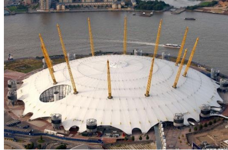
شكل (6) نظام هيكلية عالي الكفاءة متمثل في الهيكل ذو الكابلات المشدودة (Millennium, 1999) [18]
