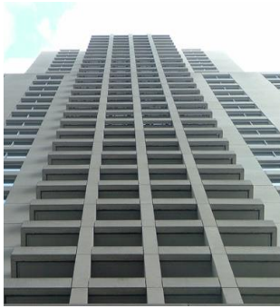
شكل (5) واجهه من ألواح أفقية مسبقة الصب مع ألواح تكسية عمودية رأسية.
