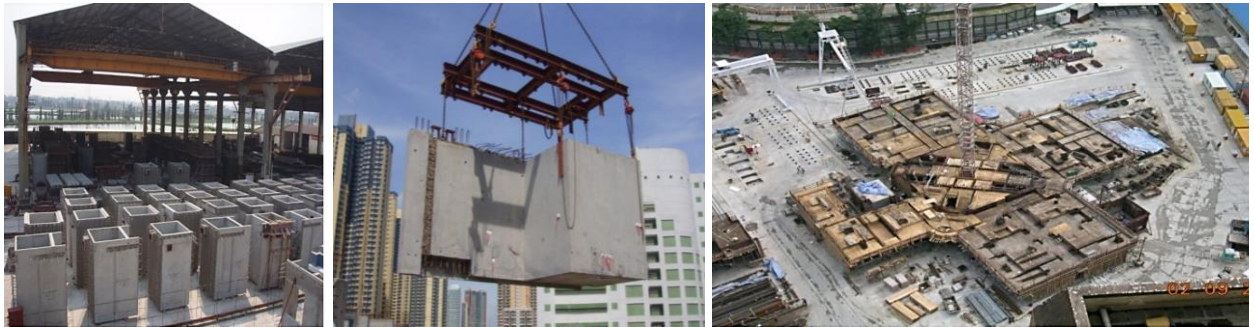
شكل (18) أعمال البناء بالوحدات الخرسانية سابقة التجهيز فى مشروع هيرموني بلوك.
