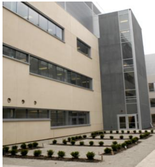
شكل (6) واجهه من ألواح أفقية مسبقة الصب مع فتحات زجاج بامتداد أفقى.
