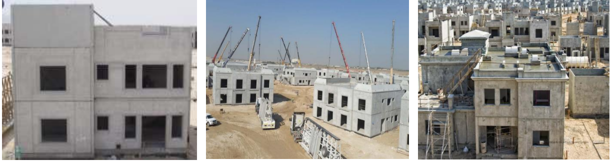
شكل (24) أعمال البناء بالوحدات الخرسانية الجاهزة فى مشروع مدينة شرق الأحمدي.
