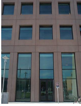
شكل (7) واجهه من ألواح الخرسانة الجاهزة مسبقة الصنع مع فتحات للنوافذ.
