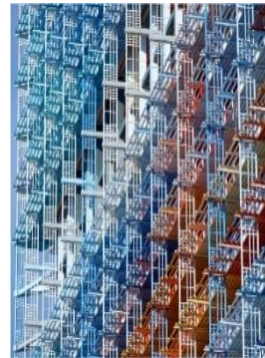
شكل (16) الوحدات سابقة التجهيز في واجهات مشروع برج مارسيلا بفرنسا.
