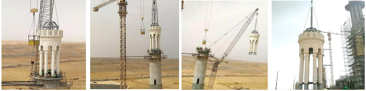
شكل (32) رفع وتثبيت المآذن الجاهزة سابقة التصنيع بمسجد الفتح العليم بالعاصمة الإدارية الجديدة.
