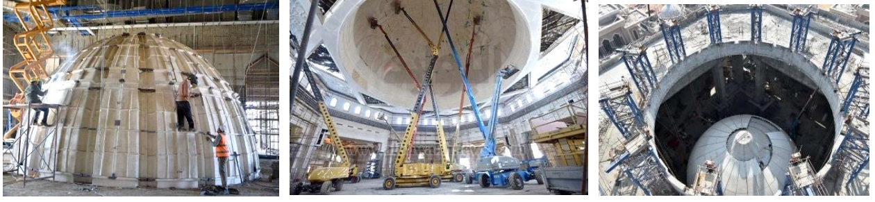
شكل (31) تركيب وتثبيت القباب الجاهزة سابقة التصنيع بمسجد الفتح العليم بالعاصمة الإدارية الجديدة.
