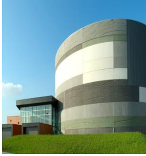
شكل (7) واجهه من ألواح الخرسانة الجاهزة مسبقة الصنع مع فتحات للنوافذ.
