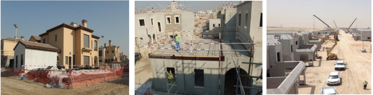
شكل (22) أعمال البناء في مشروع تطوير فيلات الفلاح.
