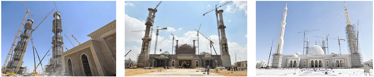
شكل (29) استخدام الأوناش البرجية فى رفع ونقل وتثبيت الوحدات الجاهزة بمسجد الفتاح العليم بالعاصمة الإدارية.
