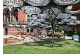
شكل (3) هذا المبنى الذي تبلغ مساحته 200 متر مربع مستوحى من مبادئ البناء الخفيفة الوزن الموجودة في الطبيعة وهي "الهياكل الليلية للفشور الخلوية للخنافس الطائرة والمعروفة باسم elytra
