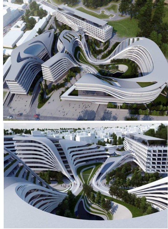
الشكل رقم (٥) مبنى بيكو بمدينة بغداد بصرىبا (٢٣)
