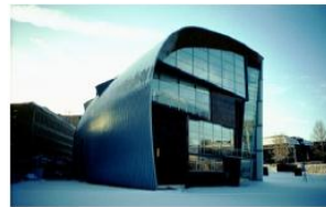
شكل رقم (11) يوضح استخدام الزنك مع نسب مختلفة من التيتانيوم في توكسية الواجهات - متحف الفن الحديث - فنلندا المرجع: www.rockwool.se
