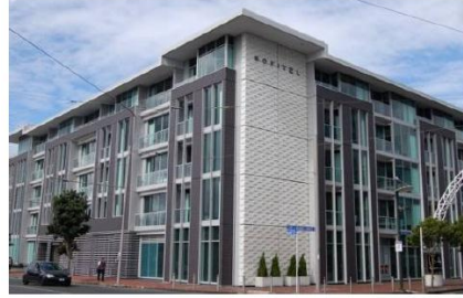
شكل رقم (6) يوضح استخدام الألواح الخرسانية المسلحة بالصفوف الزجاجي - فندق سوفيتل بنيوزيلاندا المرجع: www.eboss.co.nzlibrary
