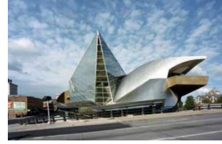
شكل رقم (9) يوضح استخدام حديد الصلب في الغلاف الخارجي - متحف توبمان للفنون ولاية فيرجينيا المرجع: www.arcspace.com
