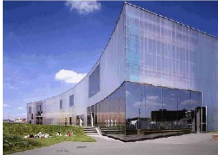
شكل رقم (17) يوضح استخدام الواح البلاستيك المعرج في تغطية نصف مبنى ساحة لانان للفنون - لندن - المعماري ريم كولهاس المرجع: www.archidim.com
