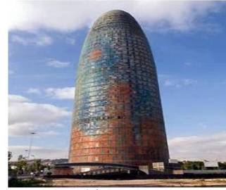
شكل رقم (14) يوضح استخدام الحوائط الستائرية في تكوين الواجهات الخارجية - مبنى تور اجبار - اسبانيا المرجع: www.arcspace.com
