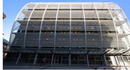
شكل رقم (10) يوضح استخدام الألومنيوم في تشكيل الواجهات الخارجية - متحف توبمان للفنون - ولاية فيرجينيا المرجع: www.arcspace.com
