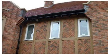
شكل رقم (7) يوضح استخدام الألواح الخرسانية المسلحة بالبولستر (GRP) في التشكيل بالطوب في الواجهات الخارجية المرجع: www.england.all.biz
