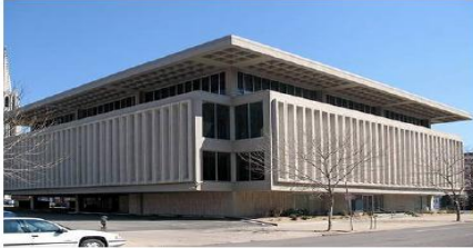
شكل رقم (5) يوضح استخدام الخرسانة سابقة التجهيز - مبنى ادارى بيمعماري وليام موشو
