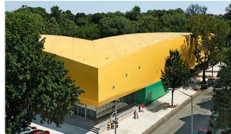
شكل رقم (15) يوضح استخدام السيراميك في الواجهات الخارجية - مبنى المكتبة المركزية - ليفربول بانجلترا المرجع: www.designbuybuild.co.uk
