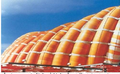
شكل رقم (16) يوضح استخدام اللدائن في المنشآت المنفوخة - معرض فوجي باليابان المرجع: www.tensint.com
