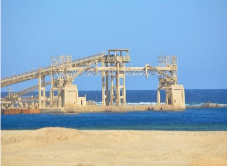
صورة (٢) السيور الناقلة للفوسفات بميناء الحمراوين
