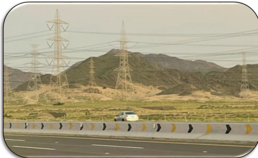
صورة (٤) تراكم الرمال فوق أبراج كهرباء الضغط العالي
