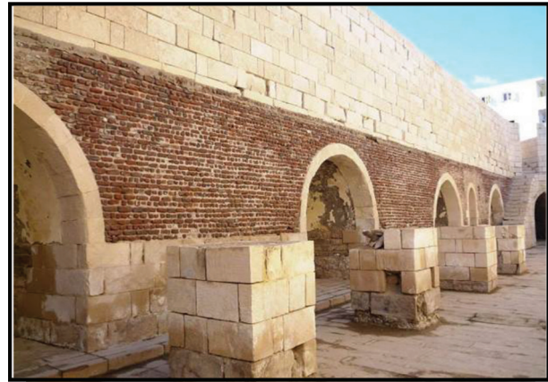
صورة رقم (٥) تأثير الرياح على جدار قلعة قايتباي
