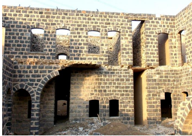
(لوحة ١٤) بقايا البائكة التي تشرف على الفناء من الجهة الجنوبية الغربية للدور الأرضي للكتلة العسكرية المحصنة بمحطة مخيط (تصوير الباحث)
