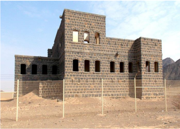
(لوحة ٣١) الواجهة الجنوبية الشرقية للثكنة العسكرية المحصنة بمحطة اصطبل عنتر (تصوير الباحث)
