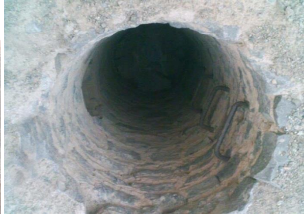
(لوحة ٢٣) فوة خزان المياه المنذر بفناء الثكنة العسكرية المحصنة بمحطة مخيط (عن https://shorturl.at/fowW1 )
