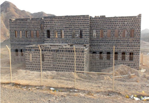
(لوحة ٤) الواجهة الجنوبية الغربية للثكنة العسكرية المحصنة بمحطة مخيط (تصوير الباحث)
