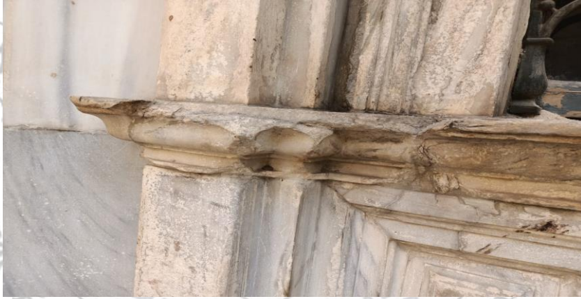
صورة رقم (1) توضح تضرر على الحوائط الرخامية نتيجة ارتفاع نسبة الرطوبة (سبيل محمد على بشارة المعز بالقاهرة)
