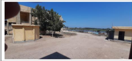
صورة (١٨) مبنى الإدارة والخدمات بمصنع أعلاف برسيق يوليو ٢٠٢٣
