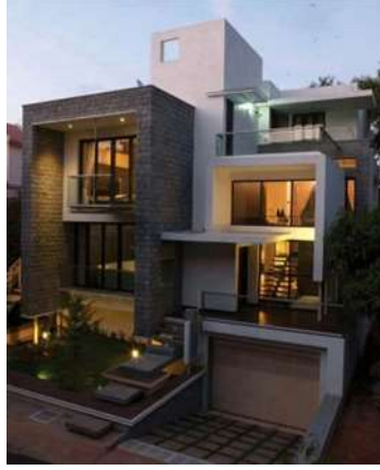
شكل (٩) تقنيات البناء الحديث في الانشاء
