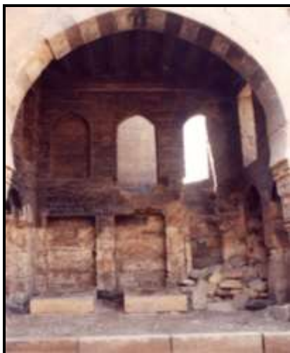
لوحة ١٦ - الإيوان الجنوبي الغربي للرباط - قبل الترميم
