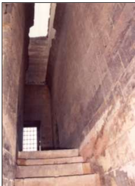
لوحة ٢٩ - الممر الفاصل بين الرباط وقبة طراباى - قبل الترميم
