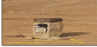
صورة (ج) أثر التجوية الميكانيكية على تفكك بعض الكتل الصخرية من أحد أعمدة المنشآت الترفيهية بالمجرى الرئيسي لوادي دجلة، ناظرًا صوب الشمال.
