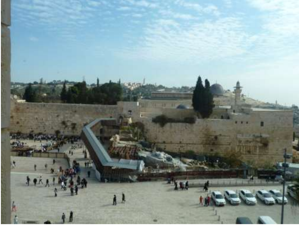
(لوحة ١١) الجسر الخشبي فوق طريق باب المغاربة التاريخي
