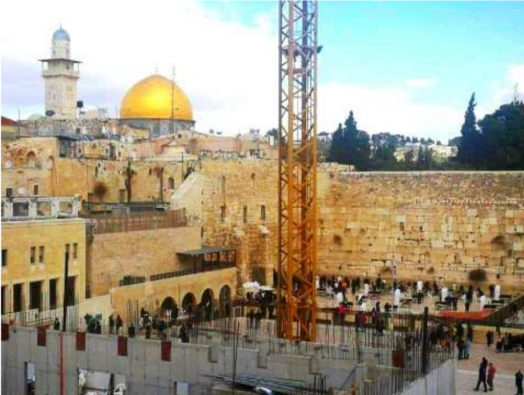
(لوحة ١٢) رافعة لإنشاء مبنى الجوهري
