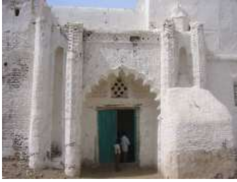
(لوحة ٦ أ) يوضح واجهة المدرسة الفرحانية بمدينة زبيد، ©تصوير الباحث
