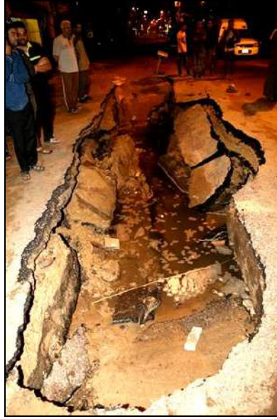
صورة (٣) انفجار مواسير مياه الشرب (شارع بور سعيد/ مدينة الشهداء)
