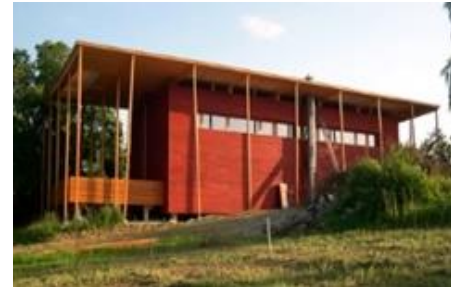
صورة (١٠): نموذج لاستخدام الطوب المصنع من قش الأرز المعاد تدويره لبناء أحد المنازل- استراليا. (Material Strategies، ٢٠١٢)
