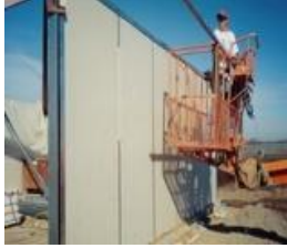
صورة (٢): تركيب ألواح الإنفيريون كحوائط خارجية. (enviroboard، ٢٠١٥)
