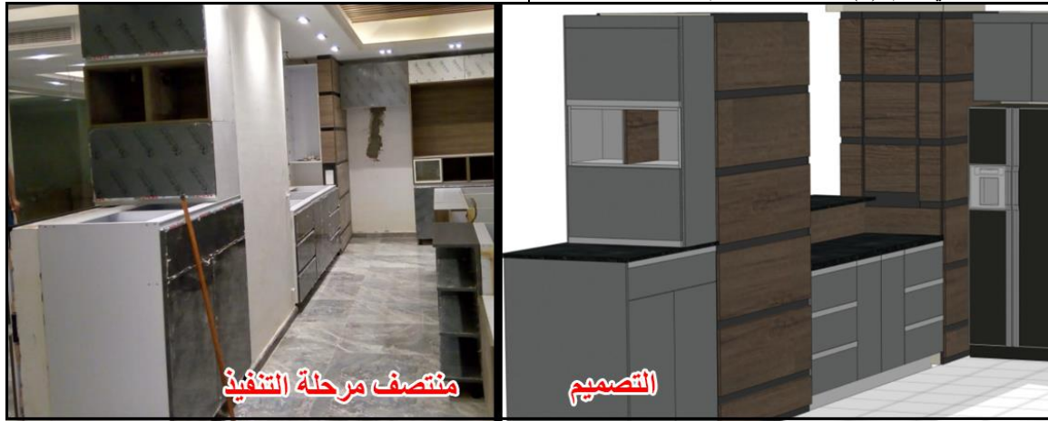
شكل (9) توضح مرحلة التصميم ومنتصف مرحلة التنفيذ لتكسيات حائط في التشطيب الداخلي لفيللا سكنية. (الباحث)
