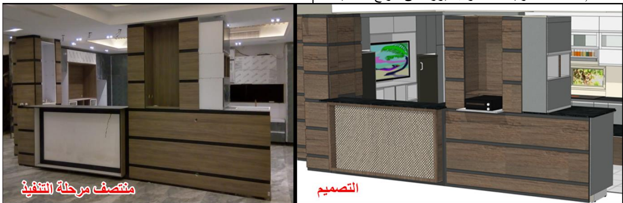
شكل (7) توضح مرحلة التصميم ومنصف مرحلة التنفيذ لتكسيات حائط في التشطيب الداخلي لفيلا سكنية. (الباحث)
