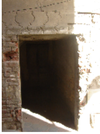
لوحة ٦٢ مدخل ثاني لأحد المنازل يعلوه عتب ذو صنجات معشقة
