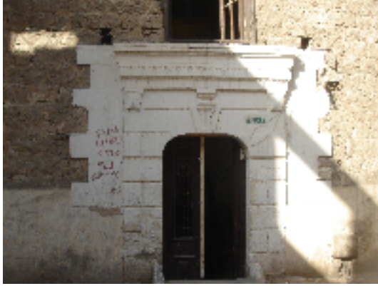
لوحة ٥٨ المدخل الحجري ذو الطراز الوافد بمنزل شارع البحر
