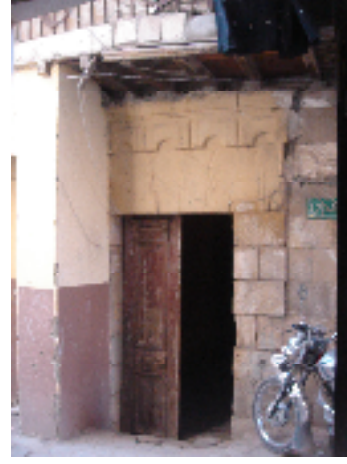
لوحة ٦١ مدخل يعلوه عتب ذو صنجات معشقة بطرة
