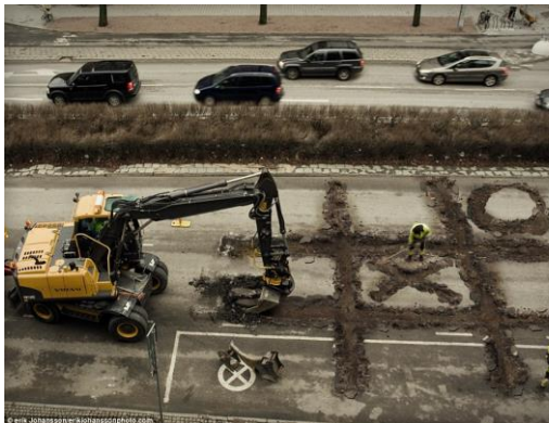
شكل (٦) صورته استراحة عمال الطرق Roadworker's Coffee Break
