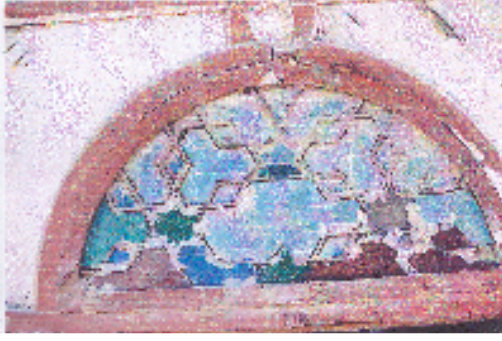
شكل(٧) نلاحظ استبدال الزجاج بالخشب الأبلكاش وتلوينه وانفصال أخشاب التعشيق فن الفتحة الى جانب ازالة مادة الشيلاك من الأخشاب وتكسر وتقصف بعضها من الإطار الخارجي
