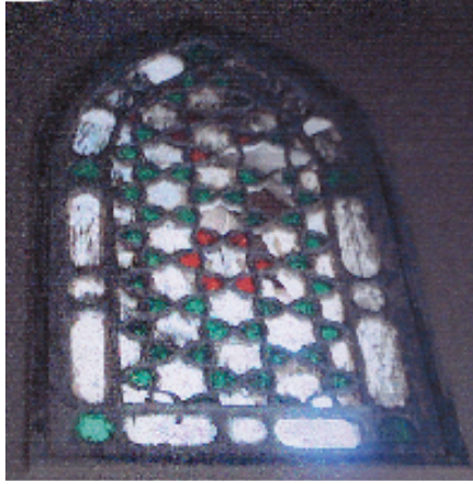
شكل رقم(٩) نلاحظ الإتساخ التام وإستبدال الزجاج الملون بالبلاستيك والزجاج الشفاف والمغير لنوعية وقيمة الأثر واللون في الفتحة بالأصل وهالك الإطار الخارجي
