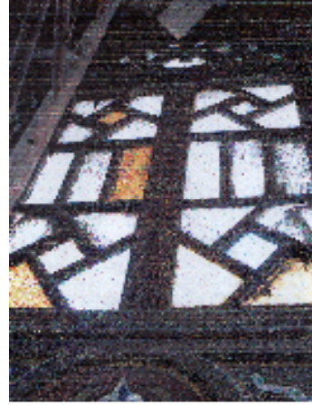
شكل رقم(٨) نلاحظ الإتساخ التام وإستبدال الزجاج الملون بالبلاستيك والزجاج الشفاف والمغير لنوعية وقيمة التصميم واللون في الفتحة بالأصل
