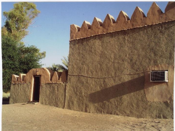
لوحة (35) الواجهة الشمالية بمسجد الخميساني (لاحظ مدخل المسجد بالطرف الشرقي من الواجهة)
