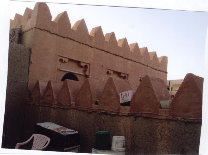
لوحة (38) الواجهة الشرقية لمسجد الخميساني و الفناء الذي يتقدمها من جهة الشرق، (لاحظ الشرافات)
