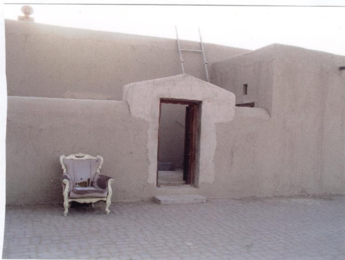
لوحة (28) الواجهة الشرقية لمسجد عيسى الظاهري و بها مدخل المسجد
