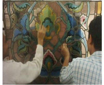
(أ) كيفية تنظيف سطح الزجاج العضوية متدرجة القوة
