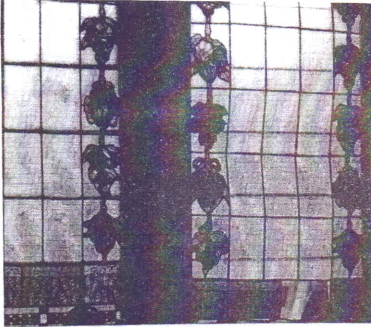
شكل رقم (٤) عيوب في حشوة من الزجاج المولف بالرصاص ناشئة عن ضعف بالهيكل الحامل
