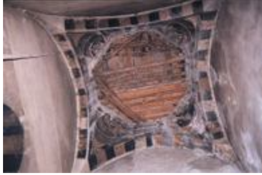
(لوحة ٢٨) المدرسة الأفريدونية: منطقة إنتقال القبة التي كانت تغطي التربة والتي حل محلها سقف خشبي مسطح.
