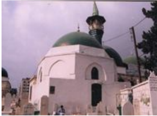
(لوحة ٧) القبة الظاهرية: الواجهتان الشرقية بصدر الصورة والجنوبية إلى اليسار.
