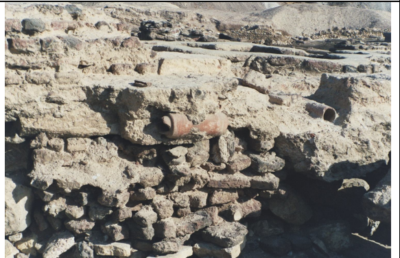
صورة رقم (٥) توضح بقايا نظام الصرف الصحي بالدار السادسة
