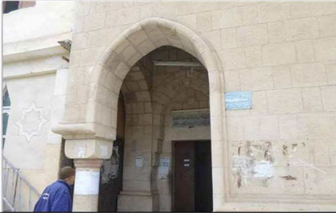
لوحة 1: الواجهة الرئيسية لمسجد الملك فاروق (الجنوبية الشرقية) ويظهر بها كرسي المئذنة تصوير الباحثان
