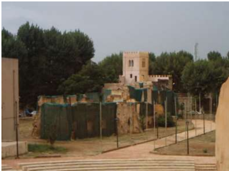
الصورة رقم ٠١ : أ- منظر عام لقصر المشور قبل الترميم
