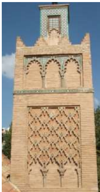
الصورة رقم ٠٥ : صورة لمأذنة مسجد سيدي أبي الحسن
