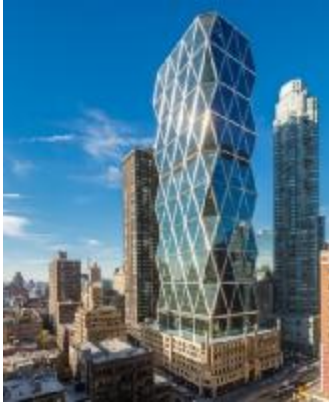
شكل (١٠) واجهة كهروضوئية بمبنى Hearst Tower
