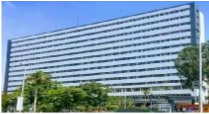
شكل (١٦) واجهة مبنى الجهاز المركزي للمحاسبات- صورة حديثة
