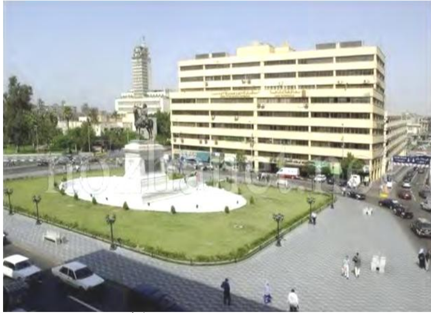
شكل رقم (٢٤) يوضح ميدان الاوبرا وبه جراج الاوبرا ومبنى المحافظة وكوبرى الازهر ونفق الازهر
