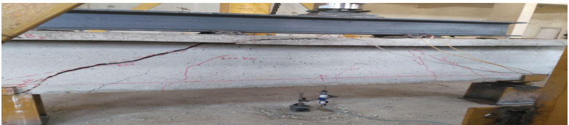
Beam (d) flange width equal 600 mm-splitting failure
