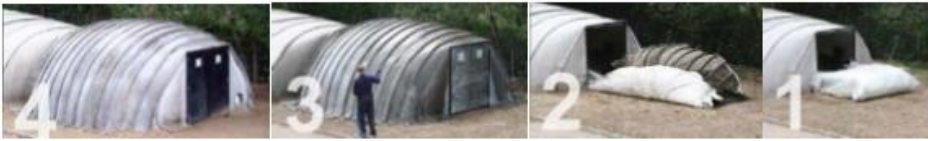
شكل (9) أربعة خطوات لتجهيز ملجأ اسمنتي من الأقمشة الإسمنتية
