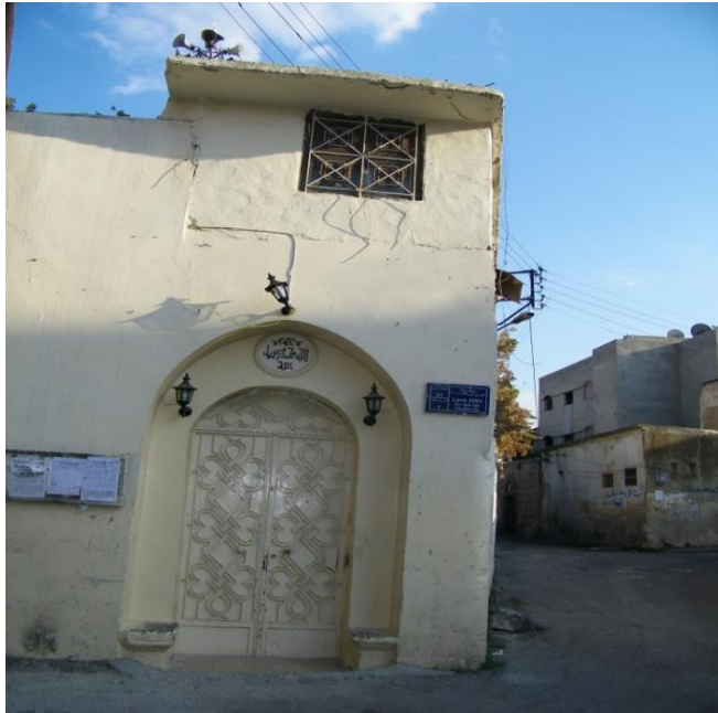
(لوحة ٣) مسجد القصير، المدخل الرئيسي للمسجد بالواجهة الشمالية
