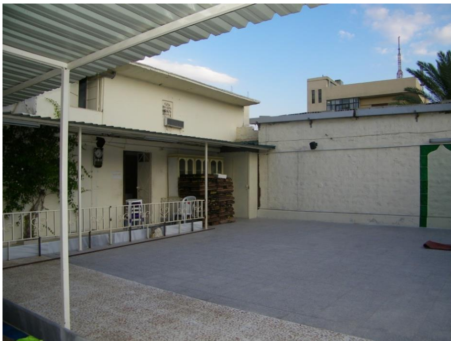
(لوحة ٢٣) مسجد القصير، واجهة الملحقات علي الصحن
