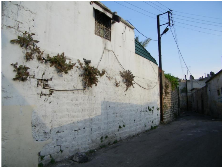
(لوحة ٤) مسجد القصير، الواجهة الغربية
