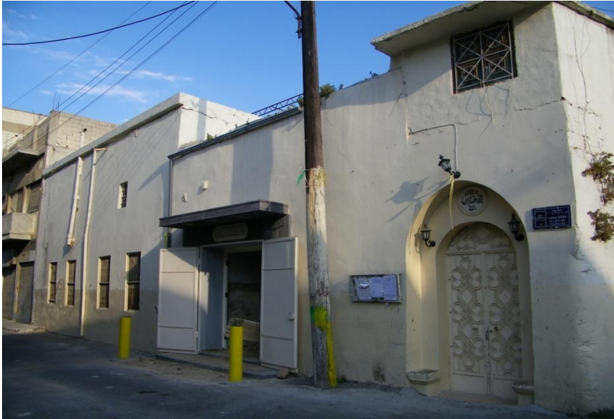
(لوحة ٢) مسجد القصير، الواجهة الشمالية
