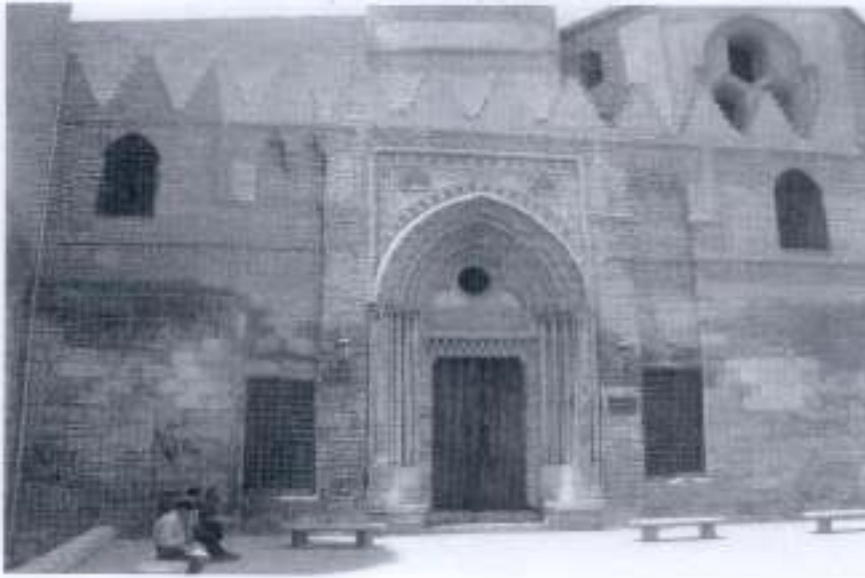
( لوحة 8 ) واجهة مدرسة الناصر محمد بن قلاوون بشرح المعز وقد ظهرت آثار المياه الجوفية على أحجار الواجهة (من عمل الباحث)
