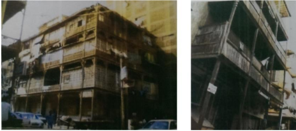
الشكل الشكل الرقم (١٢)، (١٣) يوضح نمط العمارة بمدينة بورسعيد، وهي قائمة على الأعمدة والشرفات الخشبية ممدودة على مساحة كبيرة خارجة عن المبنى وتغطي الرصيف، فتشبه نمط البواكي، (من دراسة الباحث (أحمد محمد شوقي محمد)
