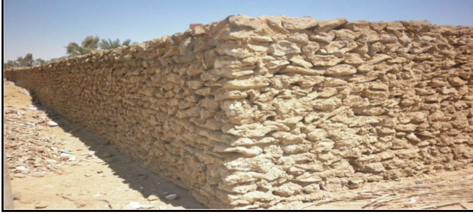
صورة (5) تأثير التجوية الملحية في سور منزل تم بناءه برواسب الكورشيف بالقبالة ناظرًا صوب الشمال
