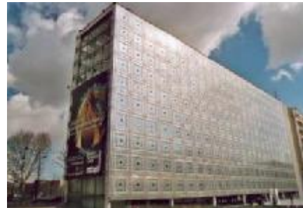
شكل (٧) يوضح صورة خارجية لمعهد العالم العربي بباريس يتضح فيها المشربيات متخذة شكل مربعات وعددها ٢٤٠ مشربية، ويعكس تنظيم الفتحات أشكال إسلامية مما أعطى للواجهة شكل المشربية
