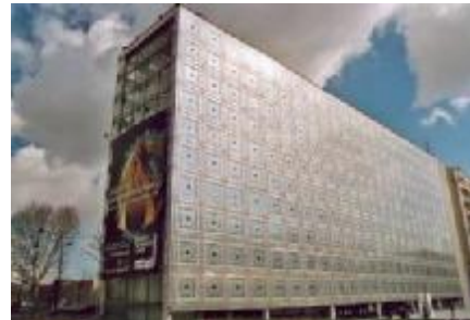
شكل (٧) يوضح صورة خارجية لمعهد العالم العربي بباريس يتضح فيها المشربيات متخذة شكل مربعات وعددها ٢٤٠ مشربية، ويعكس تنظيم الفتحات أشكال إسلامية مما أعطى للواجهة شكل المشربية
