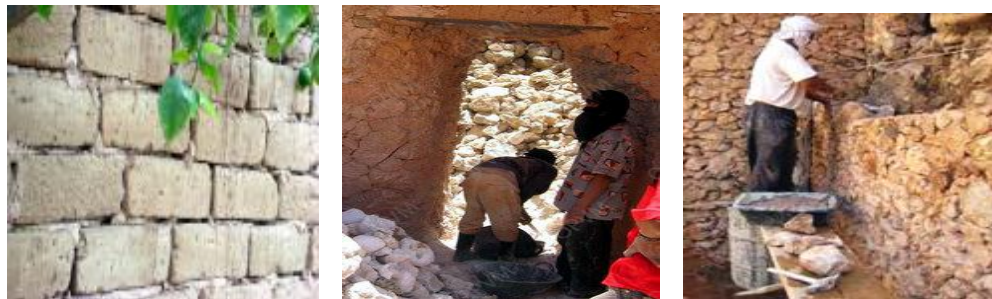
شكل رقم (٥) استخدام مواد النهو البيئية في مباني غرداية
