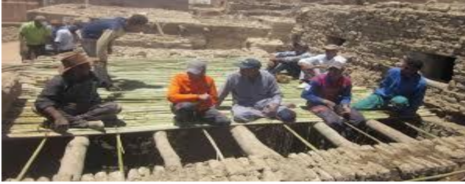
شكل رقم (١٦) طبقات الاسقف في العمارة البيئية الصحراوية المصدر مرجع رقم (١٢) مدونة الميراث www.mirathlibya.blogspot.com.eg
