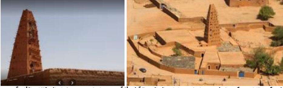
شكل رقم ( ١٣ ) موقع عام لمسجد اجاديس / اعمال الصيانة لمنذنة مسجد اجاديس باستخدام السقالات الذاتية المصدر موقع جوجل ارث
