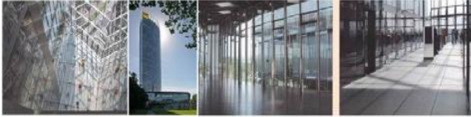
شكل (١٠) استخدام خاصية الحماية من الحريق في مبنى البريد/مدينة بون/ألمانيا
