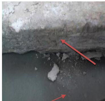
صورة (٨) توضح تفتت وسقوط أجزاء من اللوحات
