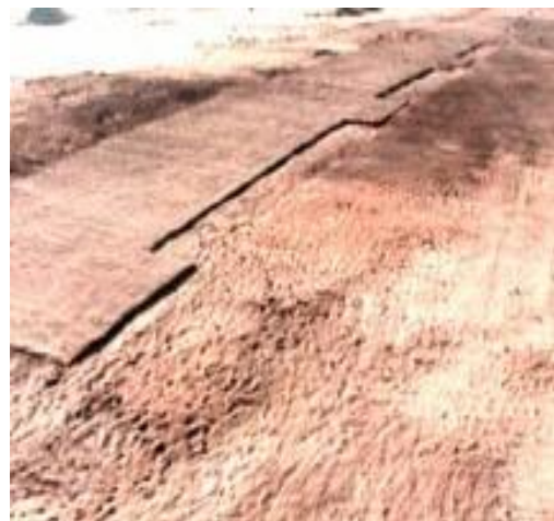
صورة (٣) توضح حفائر تل حبوة وظهور الرطوبة
