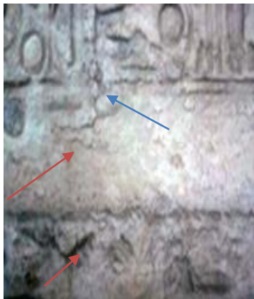
صورة (٧) توضح الشروخ والانفصالات التي تعاني منها اللوحات
