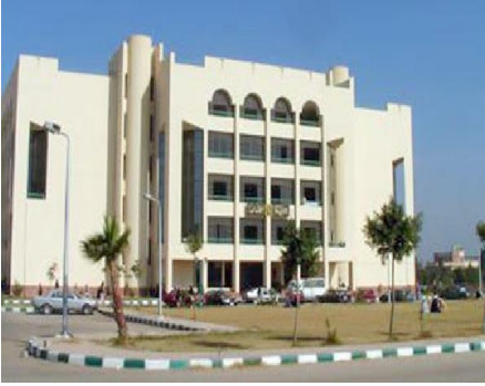
صورة (2) مبنى كلية الآداب
