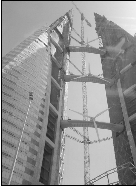
شكل (3) ثلاثة توربينات هوائية ضخمة في مبنى مركز البحرين التجاري العالمي (9).
