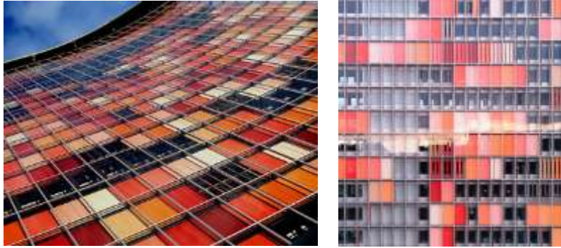
صورة رقم (3) توضح اللوحات المعدنية الملونة والتي تغطي الواجهات لعدم دخول أشعة الشمس الغير مرغوب بها داخل الفراغات. (مرجع رقم " 8 "
