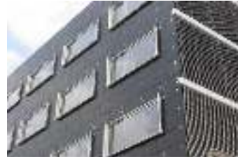
شكل (4) (للزجاج الرغوي) يستخدم كعازل للصوت ومشتتاً للضوء الخارجة.
