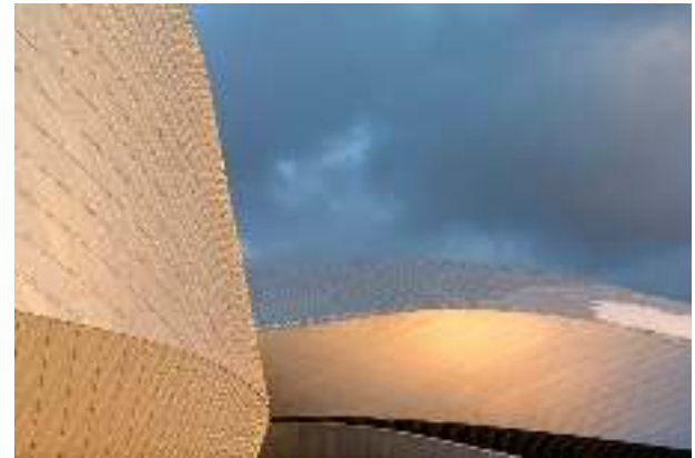
شكل (14) يوضح الواجهة المغطاة بالواح الألومنيوم
