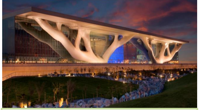
صورة (9) التمثال الفولاذي الهائل لشجرة السدره التي تدعم المظلة الخارجية للمبنى وتعمل كمدخل رئيسي لها
