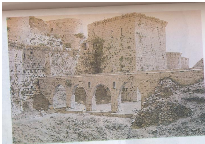
(لوحة: 8 قناة جر المياه وقناطرها الأربعة، الخندة، المحيط بقلعة الحصن (حصن الأكراد) في حمص نقلا عن طلاس: قلعة الحصن، ص:44)
