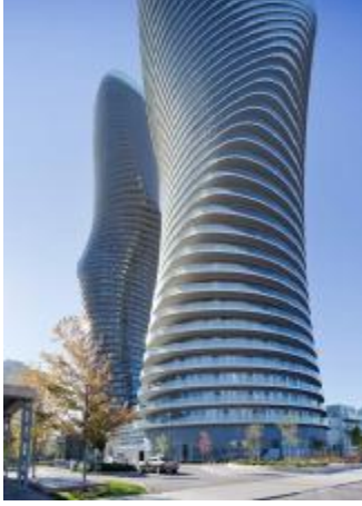
صورة (٣٤) : توضحا واجهة المبني الملتوي
