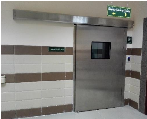
شكل (٧): باب منزلق من الإستانلس ستيل بمدخل صالة العناية المركزة المصدر: الباحث
